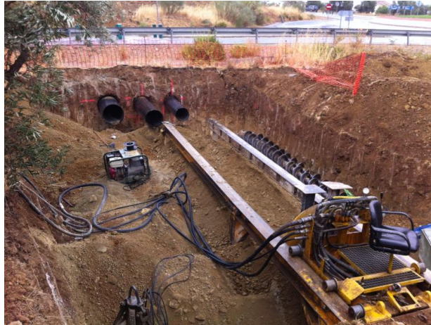
Ejemplo de cruce de vía realizado con perforadora horizontal helicoidal
