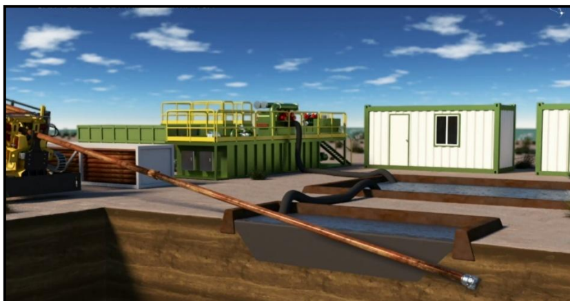
Proceso de inicio de la perforación en el pozo de ataque
