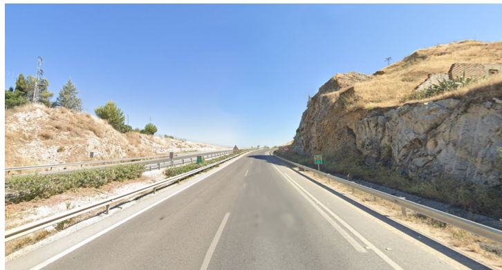
Figura 4. Vista a nivel del cruce de la C.R. de San Nicasio con la A-316. (Google Maps).
