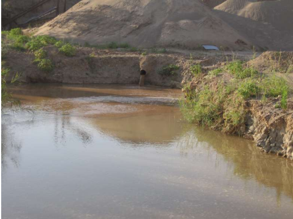
Balsa de decantación
