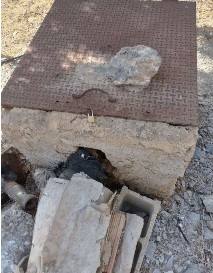
Foto 1. Captación perfectamente cerrada exteriormente. Arqueta de ladrillo con tapa metálica con candado
