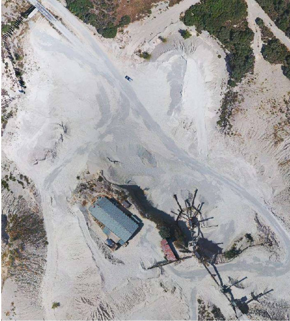
Fotografía 24. Instalaciones de planta y servicios auxiliares
