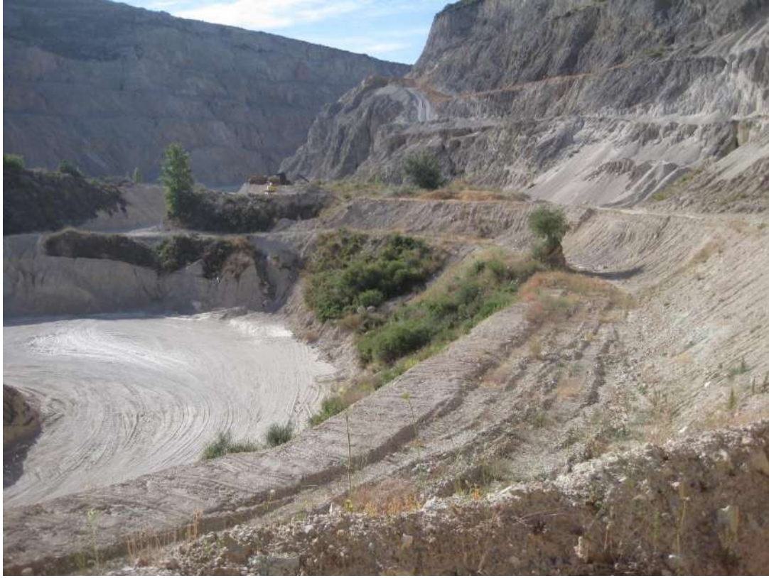
Fotografía 19. Estado actual bancos restaurados (PGMA, SLP 21/06/2019)
