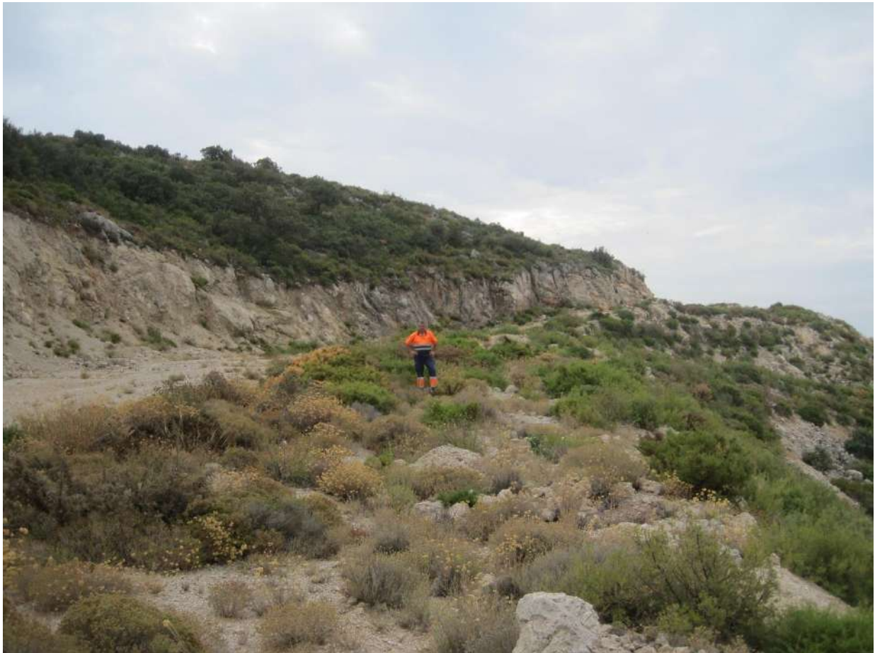
Fotografía 3. Estado del talud correspondiente a la voladura (PGMA, SLP, 11/09/2019)
