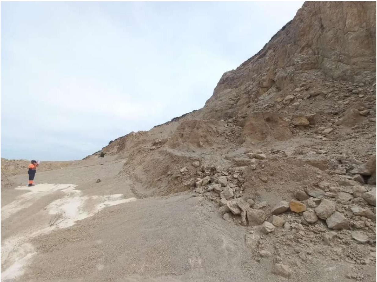
Fotografía 11. Homogenización taludes (PGMA, SLP, 13/05/2022)
