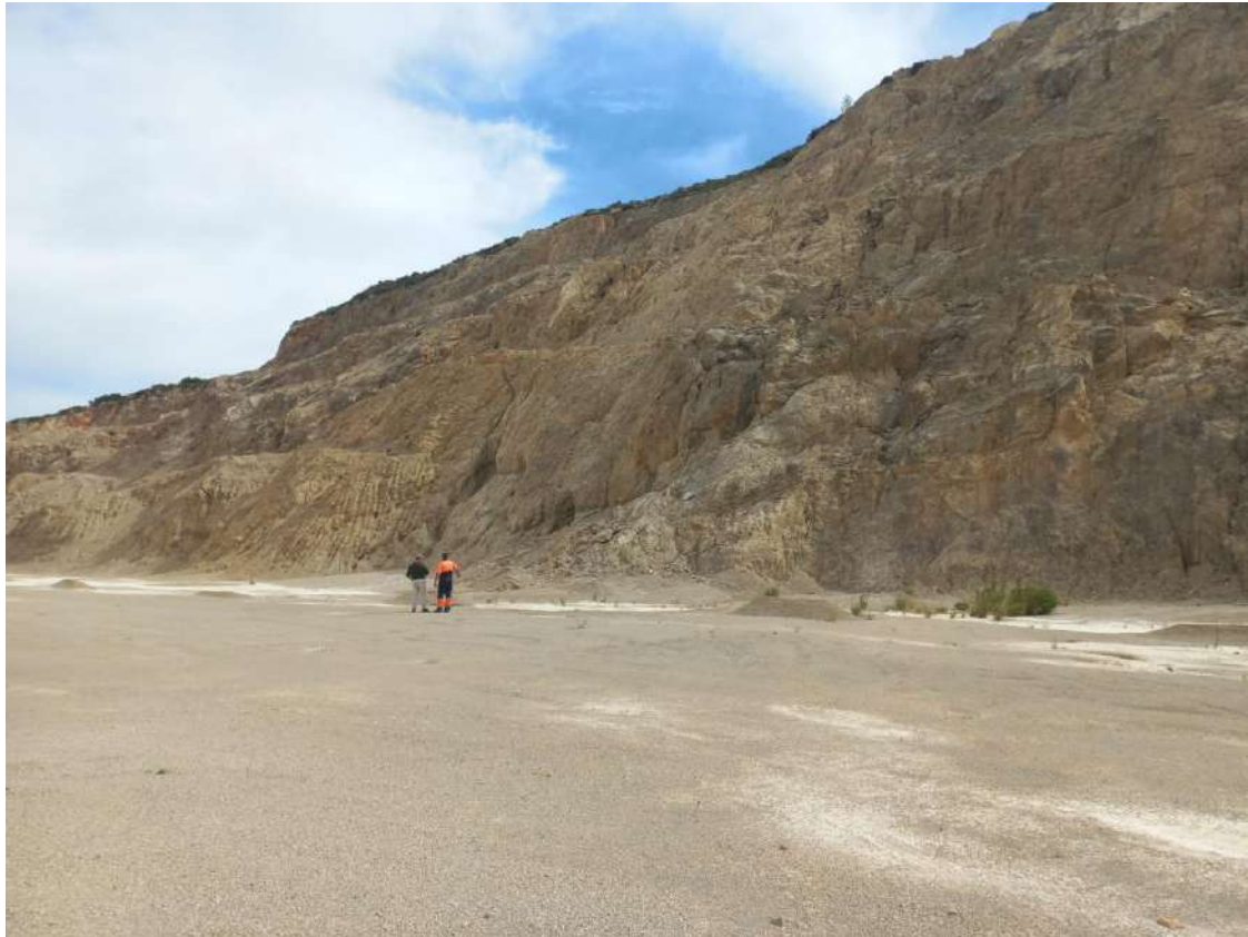
Fotografía 17. Instalación de geomallas (PGMA, SLP 13/05/2022)
