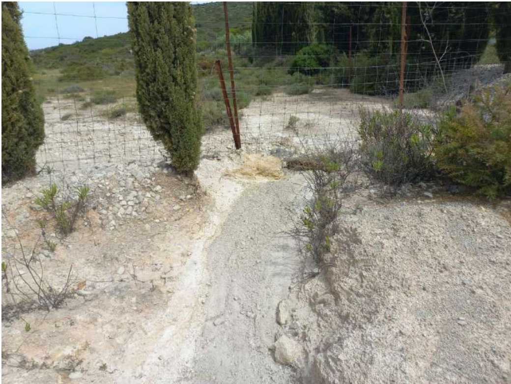
Fotografía 15. Ubicación del aliviadero (PGMA, SLP 13/05/2022)
