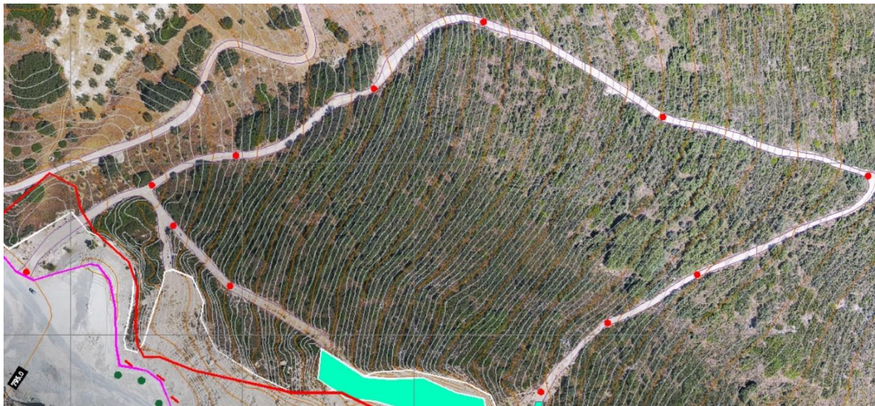
Figura 5. Construcción areneros en accesos cantera
