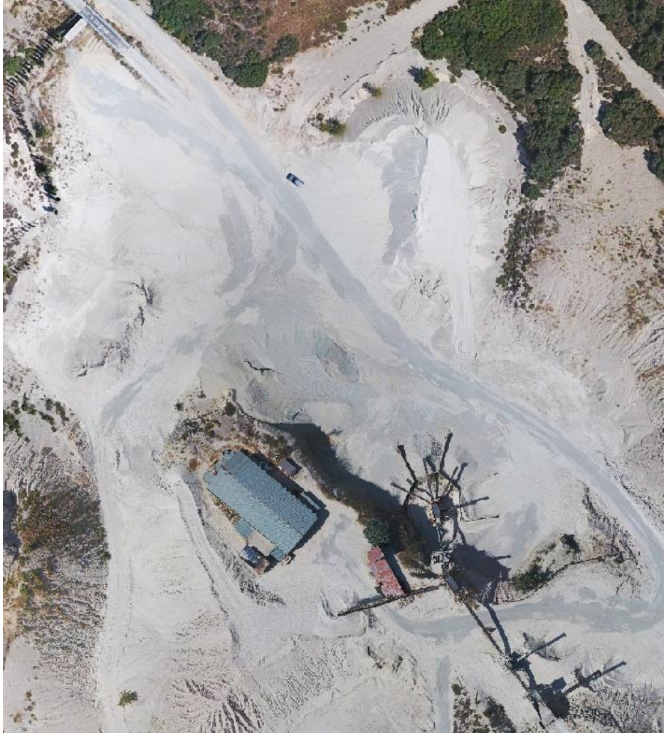
Fotografía 10. Instalaciones de planta y servicios auxiliares
