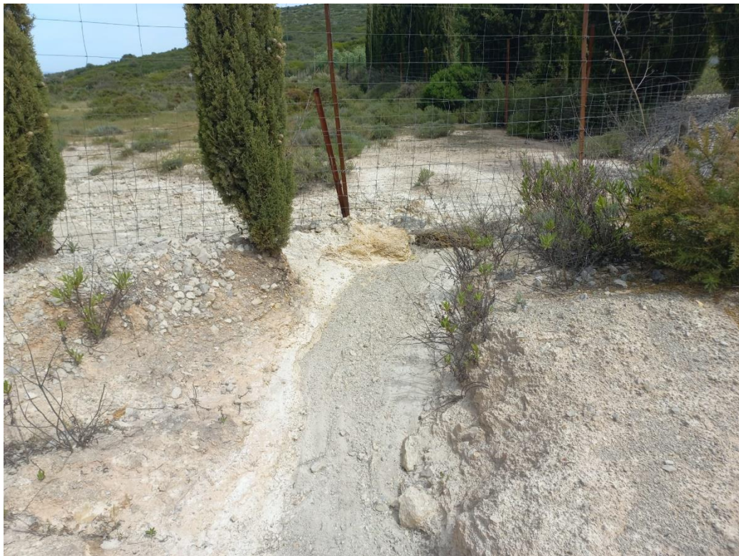
Fotografía 5. Ubicación del aliviadero (PGMA, SLP 13/05/2022)
