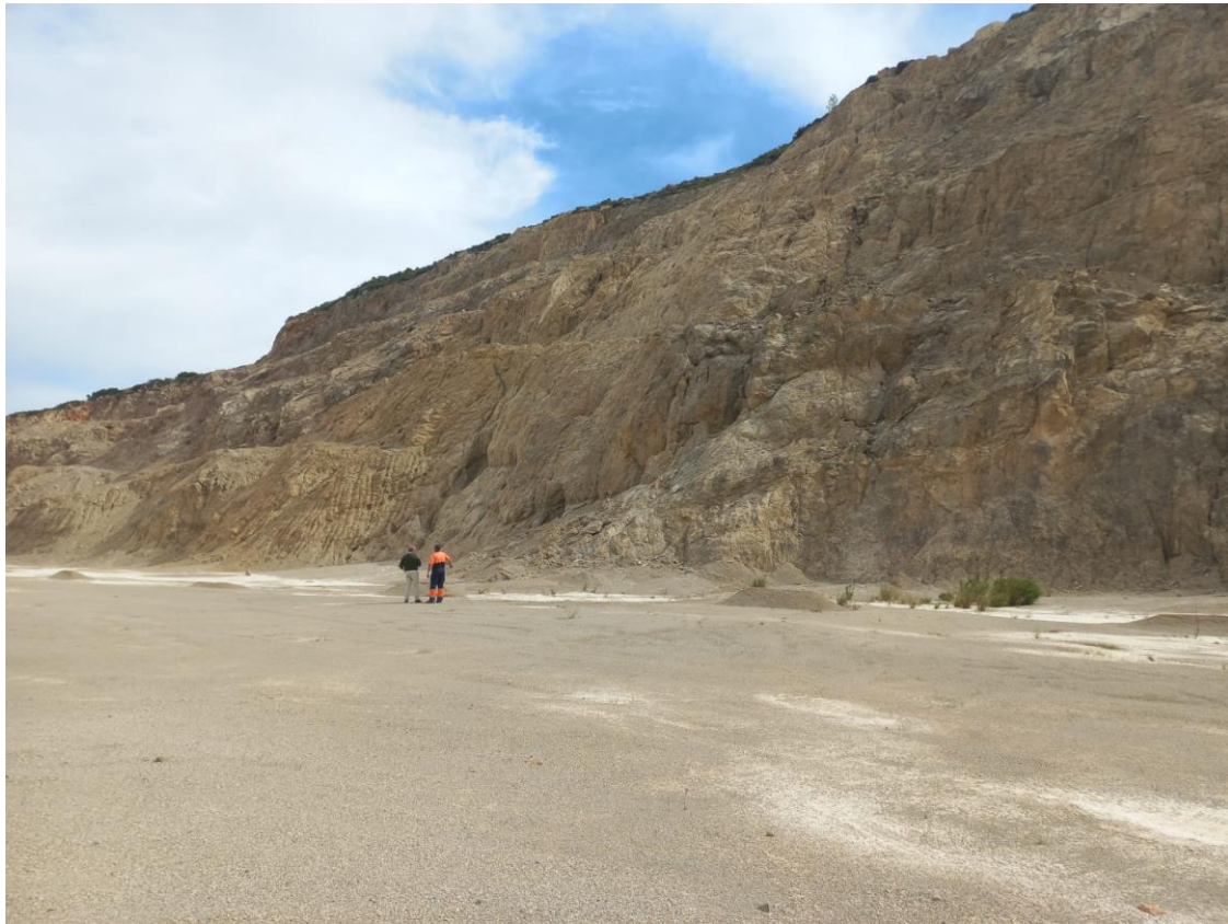
Fotografía 7. Instalación de geomallas (PGMA, SLP 13/05/2022)
