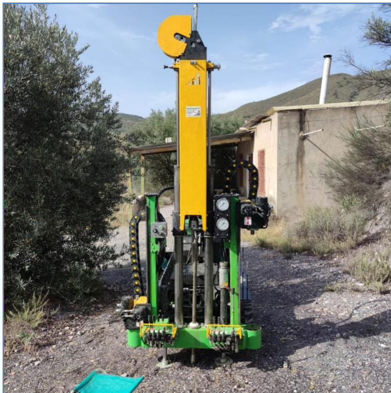
Emplazamiento penetrómetro P-6.
