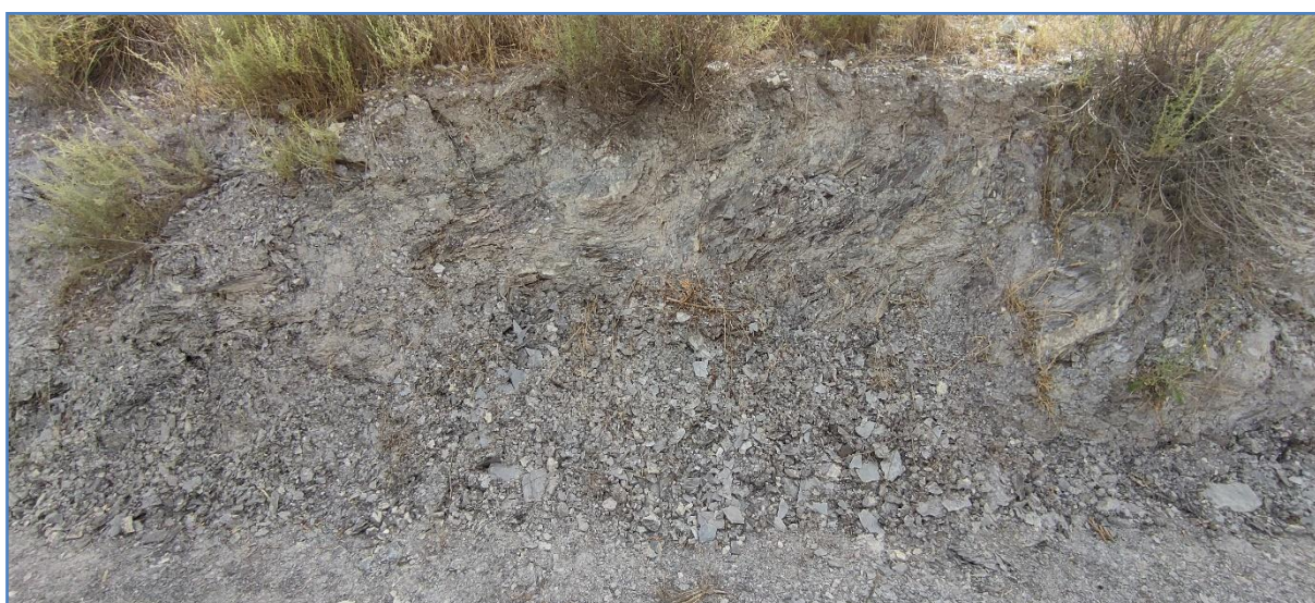
Imagen Nº 15.-Talud situado en uno de los márgenes del vial de acceso.
