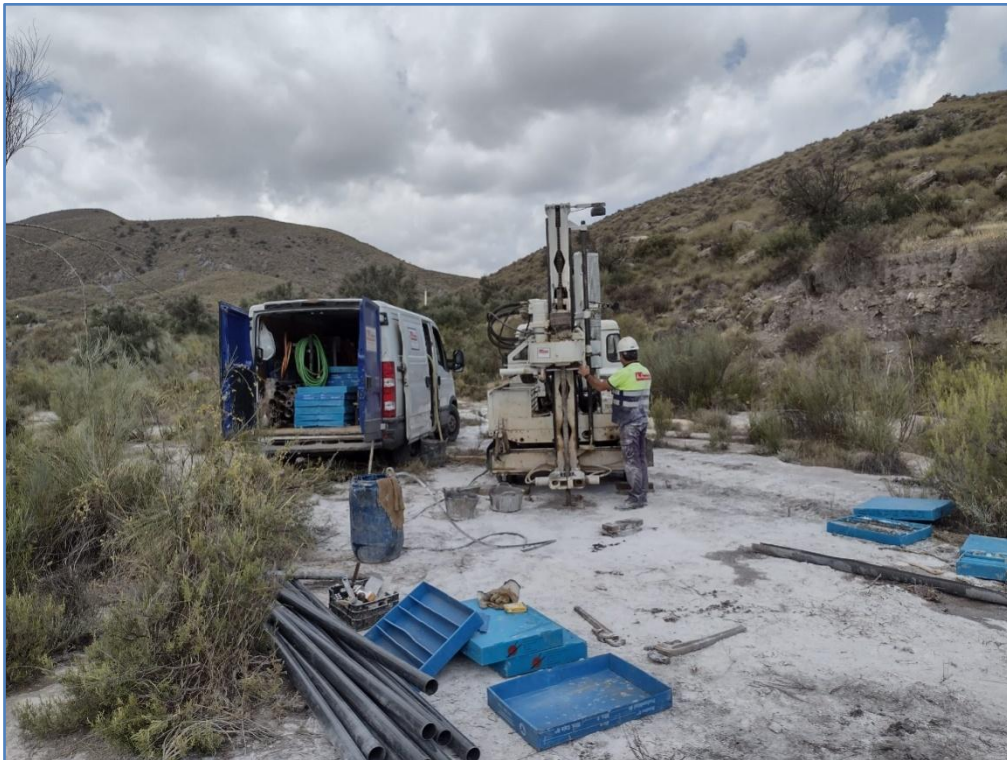
Emplazamiento Sondeo a rotación S-2
