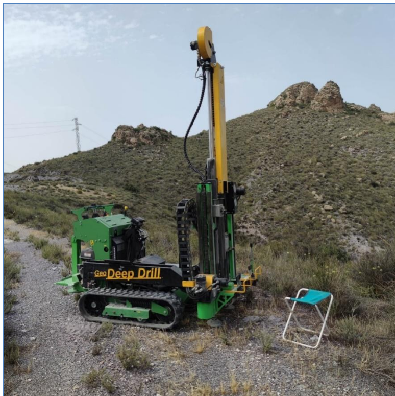
Emplazamiento penetrómetro P-8.
