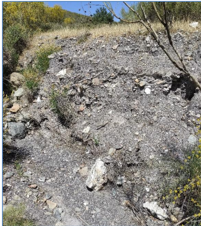
Imagen Nº 11.-Vista de talud en el extremo sur, limitando con una vaguada.
