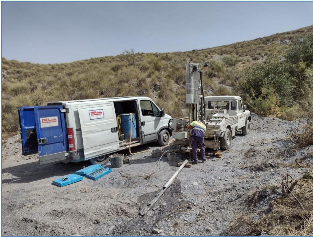
Emplazamiento Sondeo a rotación S-3
