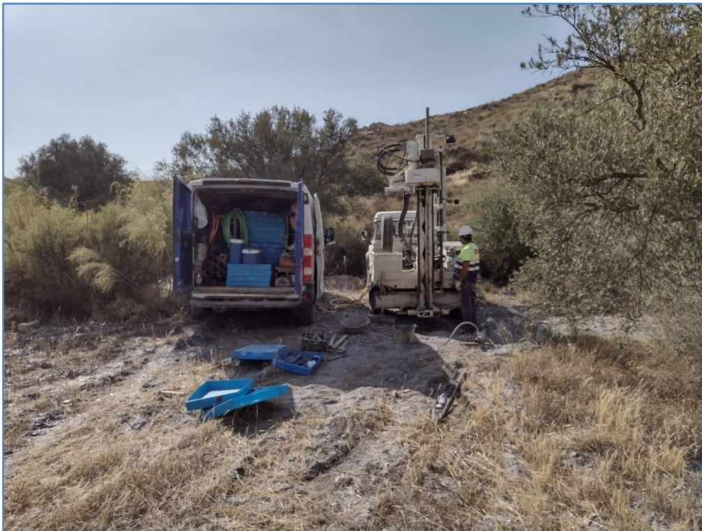
Emplazamiento Sondeo a rotación S-4
