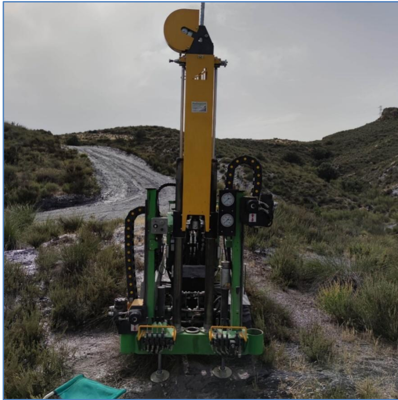
Emplazamiento penetrómetro P-1.
