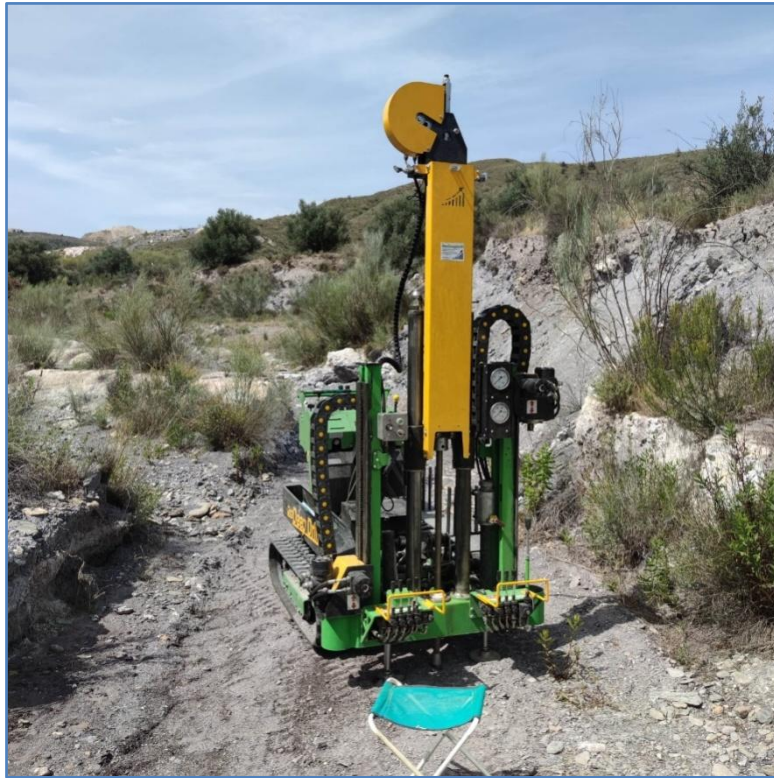
Emplazamiento penetrómetro P-5.
