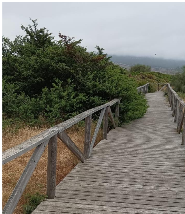
Ilustración 11. Vegetación incompatible con el paso.
