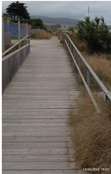
Ilustración 4. Tramo 2, vegetación invasora, caña común (Arundo donax).
