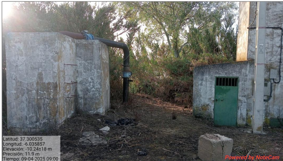
Figura 4. Aljibe de decantación y regulación.
