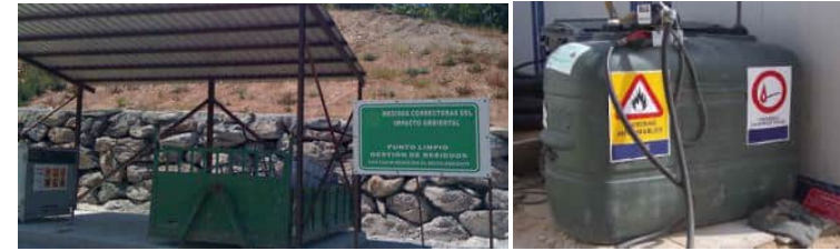
Ejemplo de Punto Limpio de Gestión de Residuos en Obra
