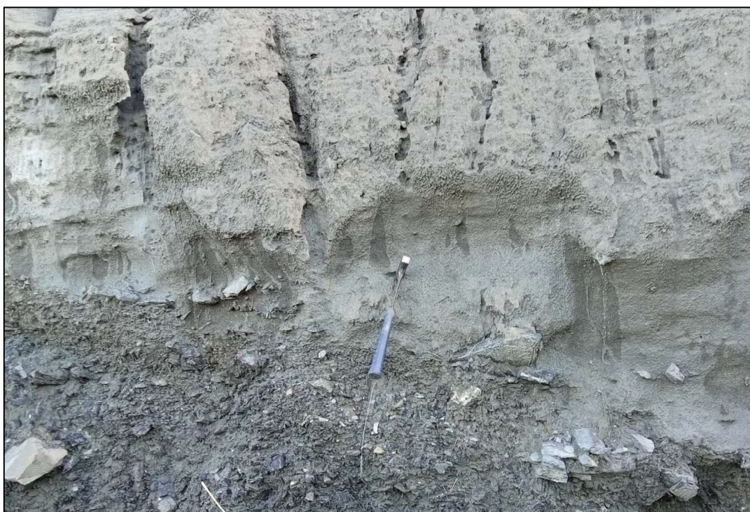
Figura 7. Pequeño depósito de estériles situado en el borde Oeste de la parte central del P.I. “Vega”. Se observa el material de proceso apoyado sobre el material de escombrera a modo de dique de contención, de bajo ángulo.
