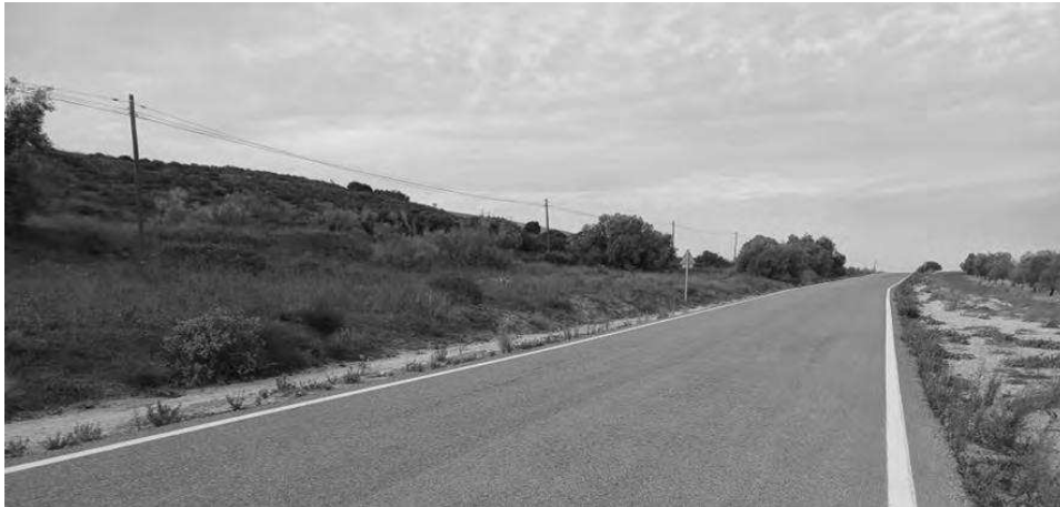
Figura 59. Carretera CA-6102, sentido Bornos-Espera
