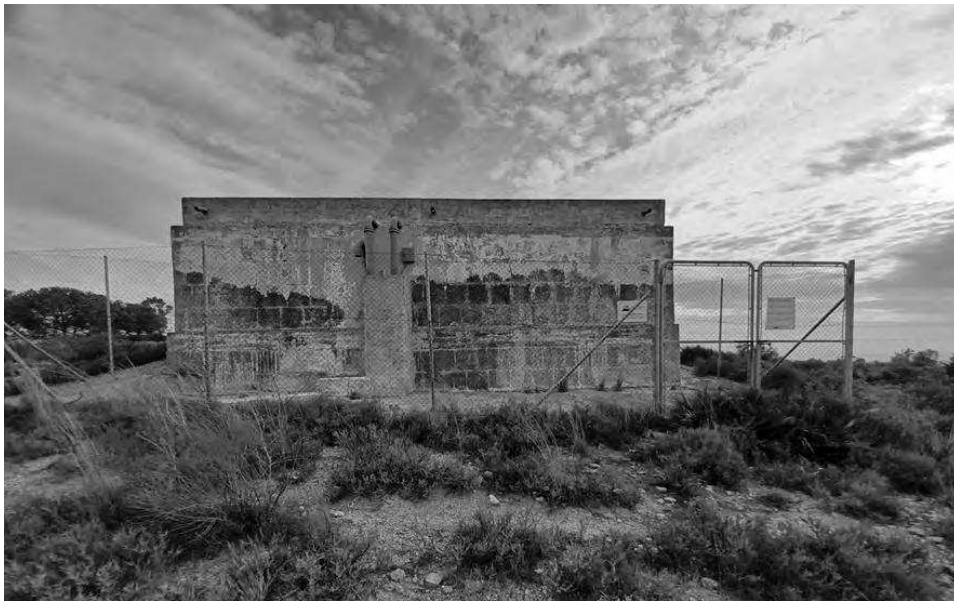
Figura 67. Depósito de almacenamiento de agua El Carmen, dentro del P.I. Bornos
