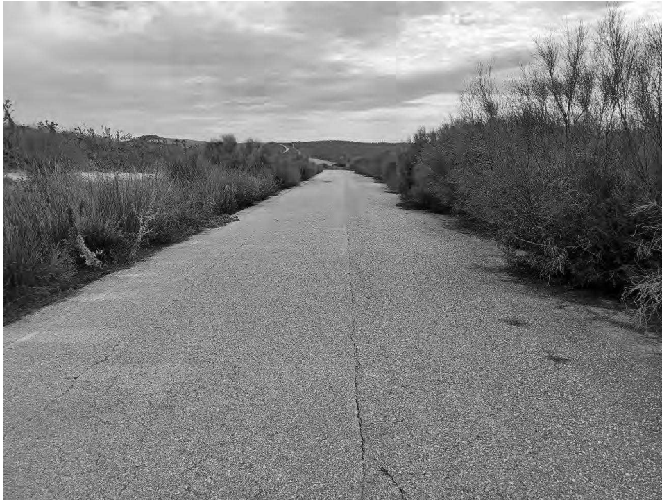
Figura 81. Vía pecuaria, Colada de Jerez a Bornos, acceso al P.I. Bornos
