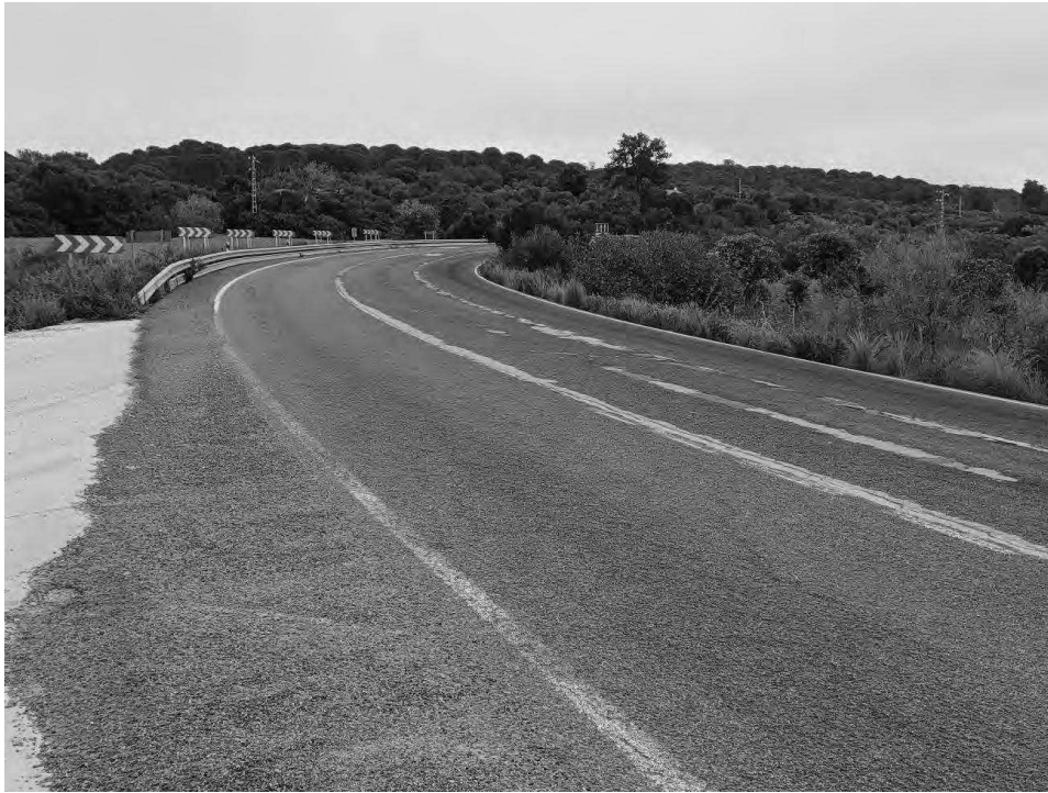
Figura 60. Carretera A-384, sentido Arcos de la Frontera-Bornos
