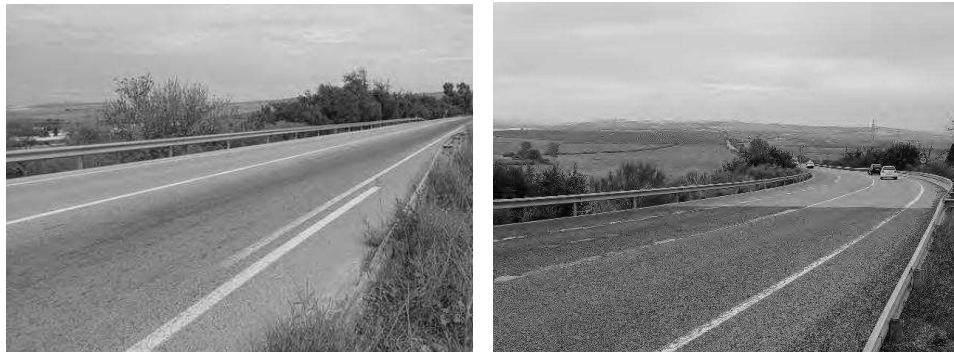
Figura 79. Carretera A-384 acceso al P.I. Bornos , a la izquierda sentido Bornos, a la derecha sentido Arcos de la Frontera
