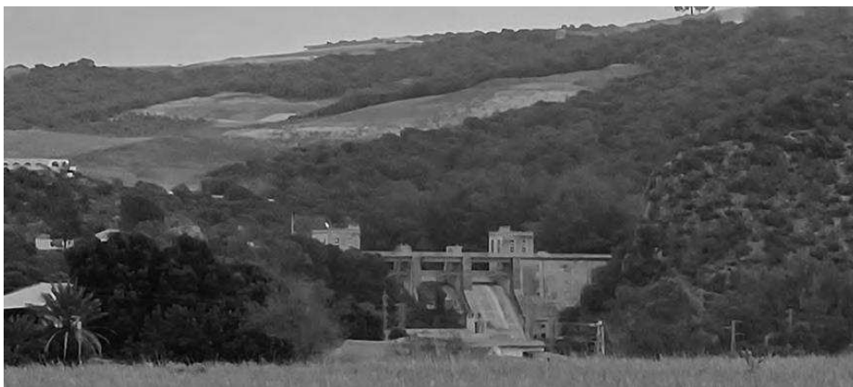
Figura 64. Central hidroeléctrica Bornos
