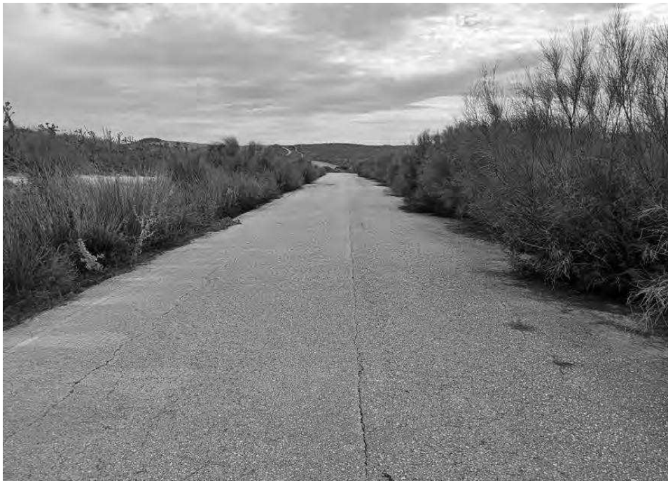
Figura 5. Vía pecuaria, Colada de Jerez a Bornos, acceso al P.I. Bornos
