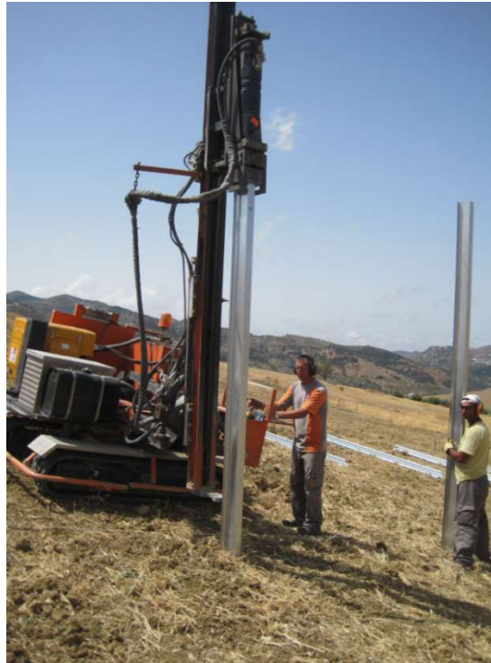
Ejemplo de hincado de estructura
