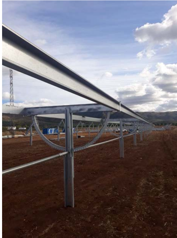
Estructura tipo seguidor a un eje para instalación de módulos Fotovoltaicos.
