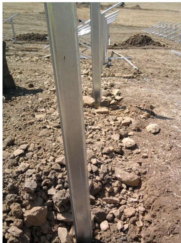
Ejemplo de hincado de estructura
