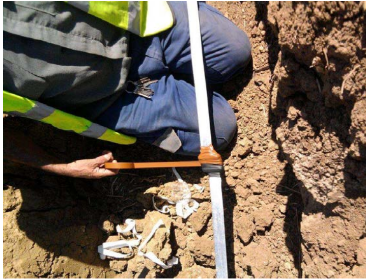
Encintado con cinta autovulcanizante y cinta aislante
