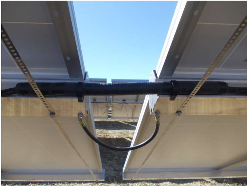
Unión de la estructura mediante cable de cobre 35 mm 2
