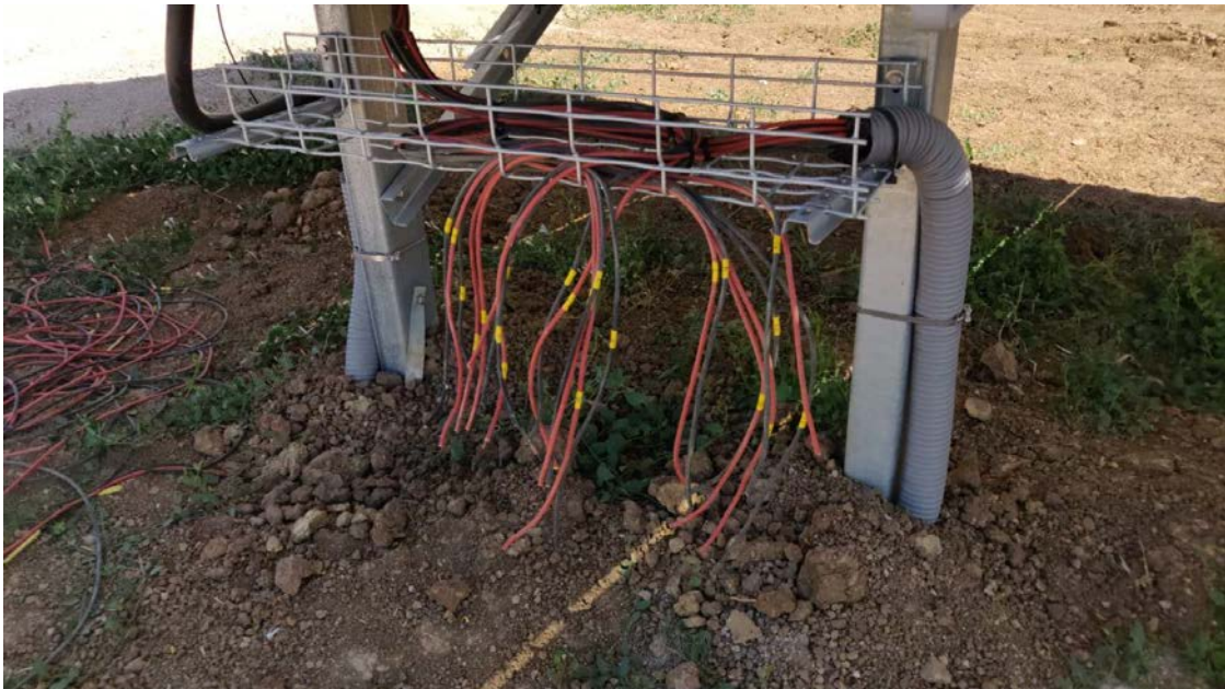
Ejemplo de protección mecánica
